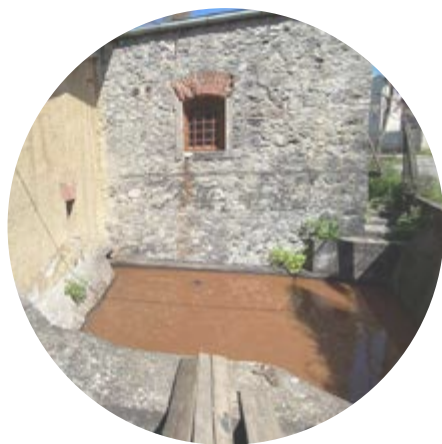
2. KAMENNÁ VYPÚŠŤACIA NÁDRŽ
