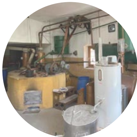
1. FUNGUJÚCA DESTILAČNÁ KOLÓNA
